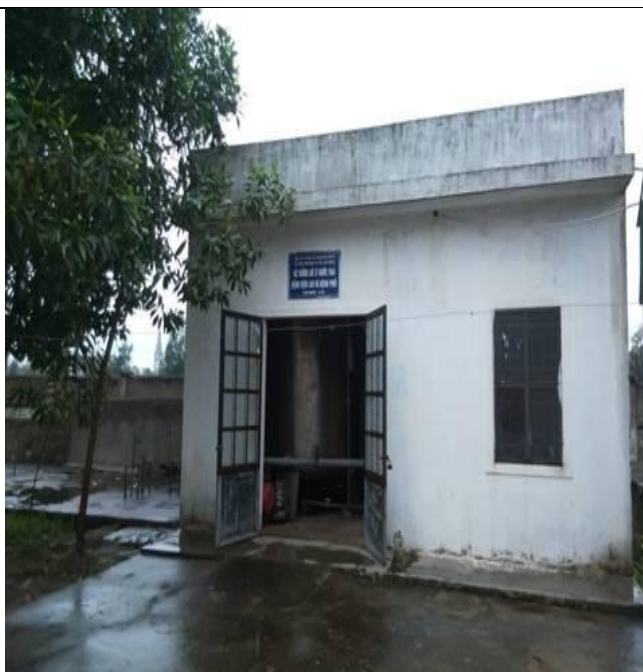
3. Nhà điều hành xử lý nước thải trước cải tiến
