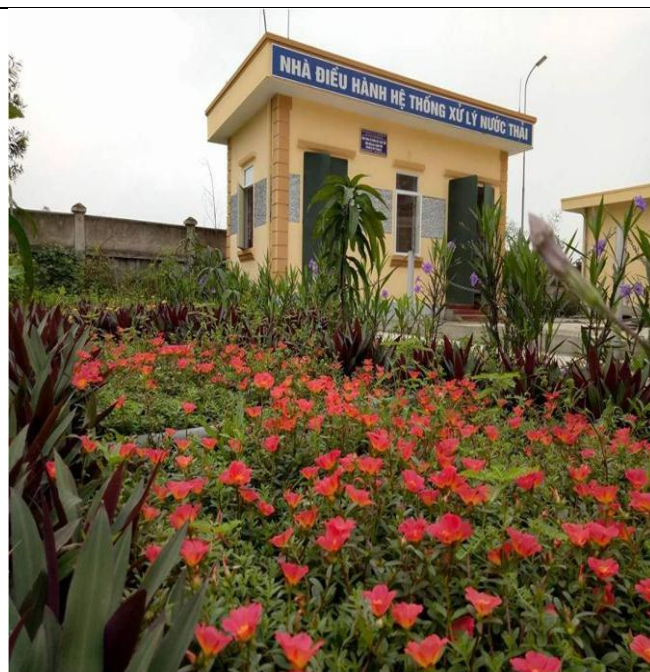
3.1 Nhà điều hành xử lý nước thải sau cải tiến
